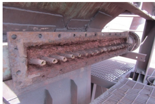
شکل ۲. افشانک های تغییر شکل یافته ناکارا که آب را بر گلولی اسپری نمی کنند.
