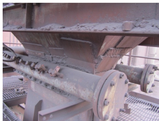
شکل ۱. خوردگی و ساییدگی سطح خارجی دور تا دور گلولی ونچوری، عدم بسته بودن همه پیچ های درپچه های دسترسی روی بدنه اسکرابر ونچوری و درزندهای دارای نشی محل افشانک ها.
