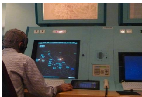
شکل ۱- ایستگاه کاری کنترلر ترافیک هوایی
