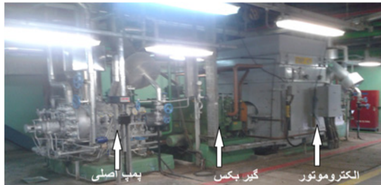
شکل ۱ - نمای کلی نمونه پمپ آب مورد بررسی
