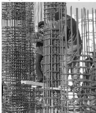
آرما توربندی ایستاده و در ارتفاع شانه
