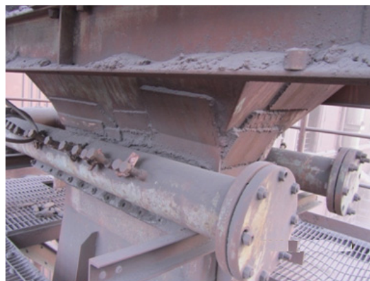
شکل ۱. خوردگی و ساییدگی سطح خارجی دور تا دور گلوبی ونچوری، عدم بسته بودن همه پیچ های درپچه های دسترسی روی بدنه اسکرابر ونچوری و درزبندهای دارای نشی محل افشانک ها.
