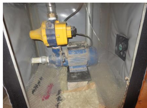
شکل ۳- نمای داخلی محفظه آکوستیک به همراه محل نصب سیستم تهویه
